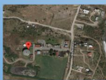
Figura 1: Planta de tratamiento de aguas residuales Alseseca-Sur, San Francisco Totimehuacán, Puebla.
