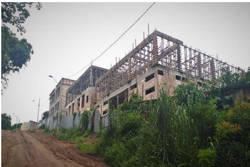
Figura 21: Visión desde la calle de abajo de la construcción de edificios próximos al río Tapajós. Foto: Damilles Borari, el 27 de febrero de 2021.
