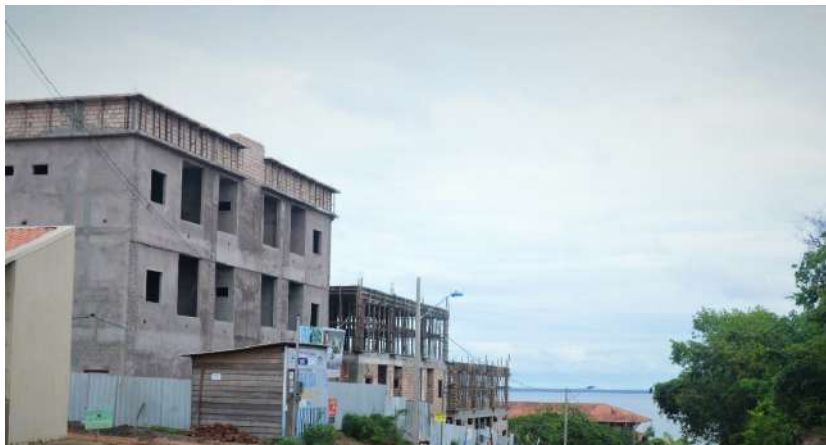
Figura 20: Visión desde la calle de arriba de la construcción de edificios próximos al río Tapajós. Foto: Damilles Borari, el 27 de febrero de 2021.
