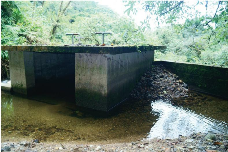
Foto 2. Caja de captación donde solo se entuba una parte del río.
